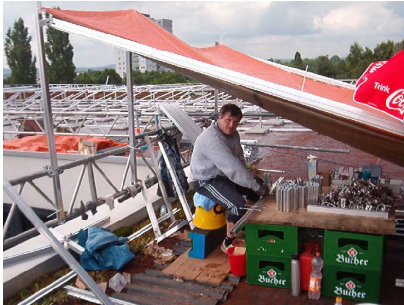
Montage der Winkel für das Solargestell
