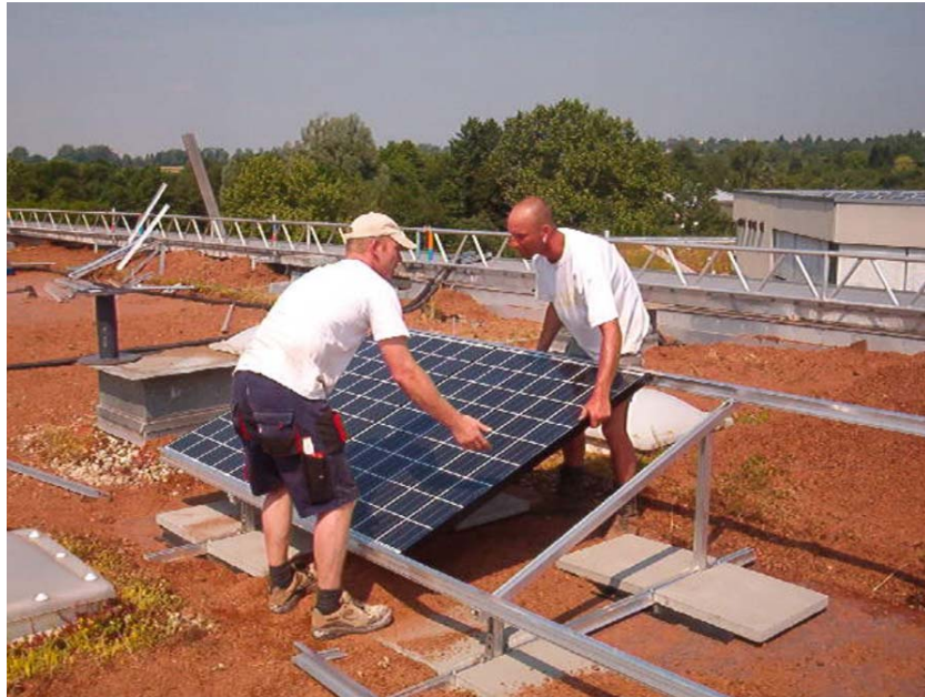
Einlegen der Solarmodule in das fertige Gestell
