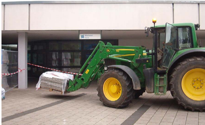
Anlieferung der Waschbetonplatten zur Gewichtsbelastung des Trägersystems
