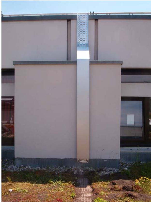
Kabelrinnenmontage auf das obere Dach zu den Solarmodulen
