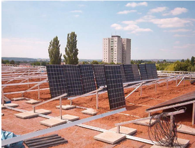
Verkabelung der Solarmodule mit speziellem Solarkabel
