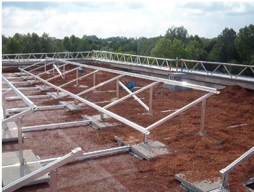
fertiges Gestell mit Gewichtsbelastung und Granulataufschüttung
