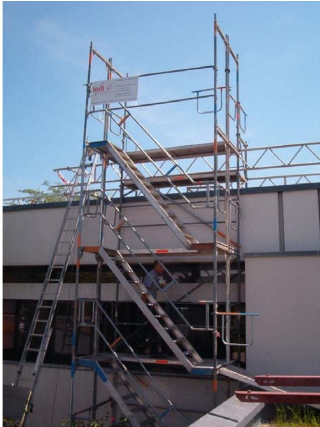
Treppenturm aufs Schuldach mit Schrägaufzug links
