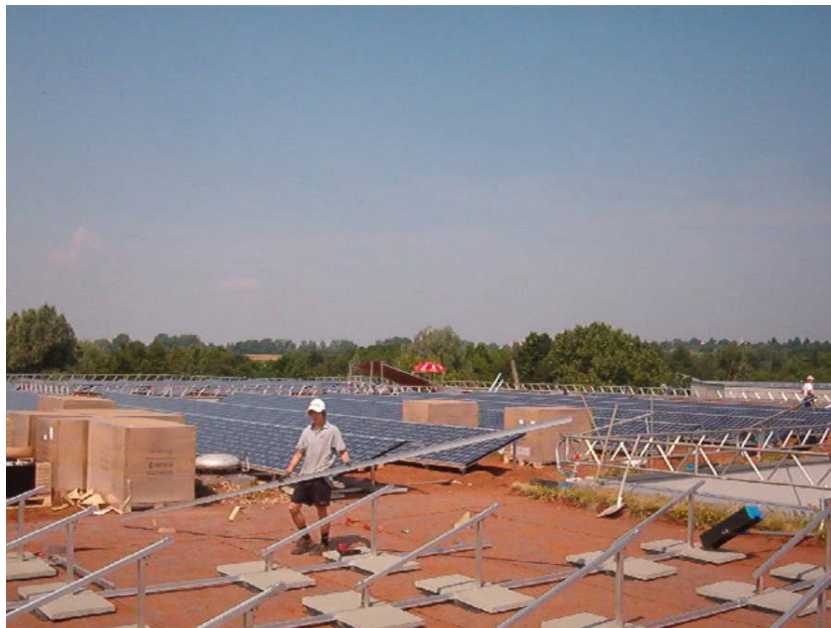
Weiterbau des Trägergestells, nachdem ein Drittel der Dachfläche mit Modulen belegt und verdrahtet ist
