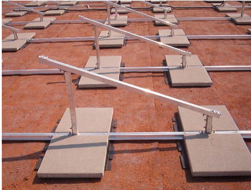
Grundgestell und Renosolplatten mit Waschbetonplatten als Gewichtsbelastung belegt
