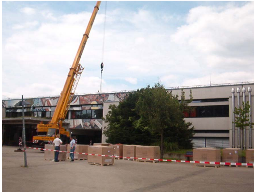
Anlieferung der Solarmodule im Schulhof mit dem Autokran auf das Schuldach
