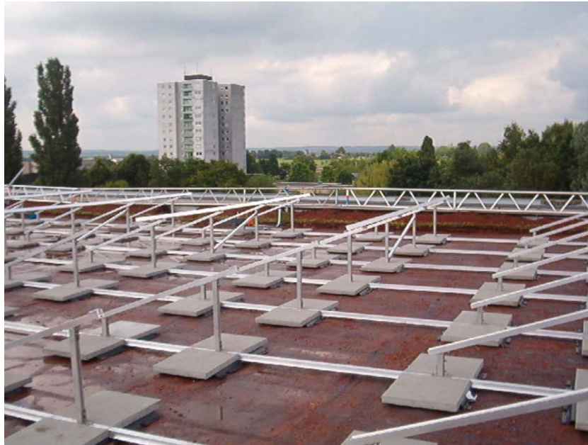
teilweise fertiges Gestell mit Gewichtsbelastung
