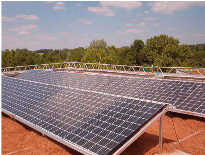
fertig eingelegter String
