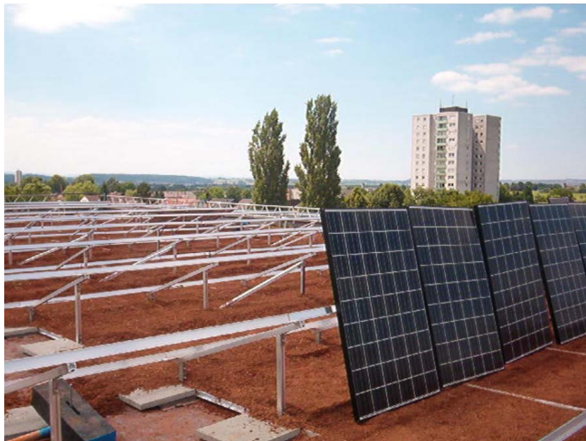
Vorbereitung der Solarmodule zum Einlegen in das Gestell
