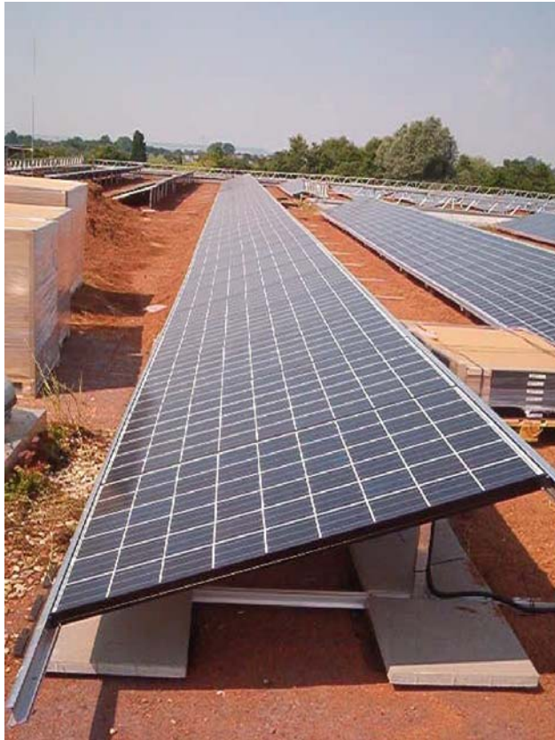
Blick über \frac{2}{3} der aufgebauten Solarmodule in einer Reihe auf dem Dach
