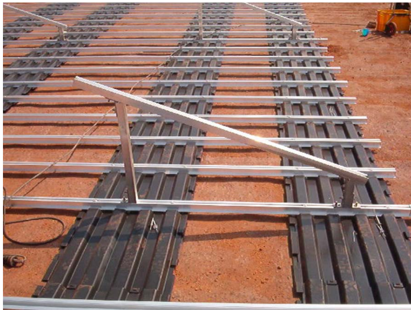
Grundgestell auf Renosolplatten montiert bzw. genietet
