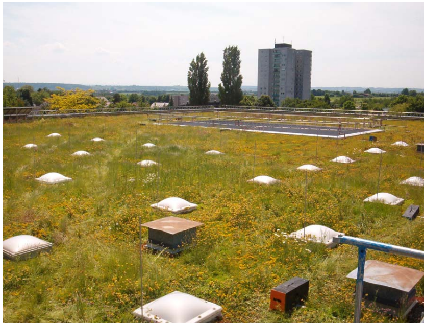
Dachansicht mit Dachbegrünung vor der Montage
