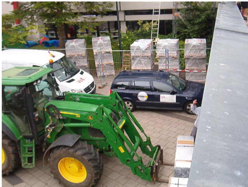
Anlieferung der Dachaufständerung und der Solarmodule
