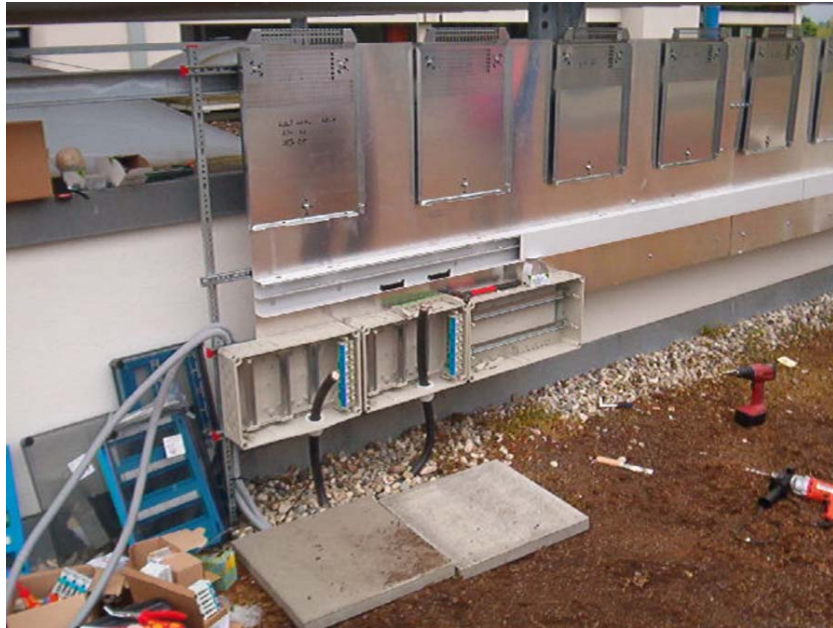
Montage der Sicherungskästen und Überspannungsverteilung DC-seitig und der Trägerplatten für Wechselrichter
